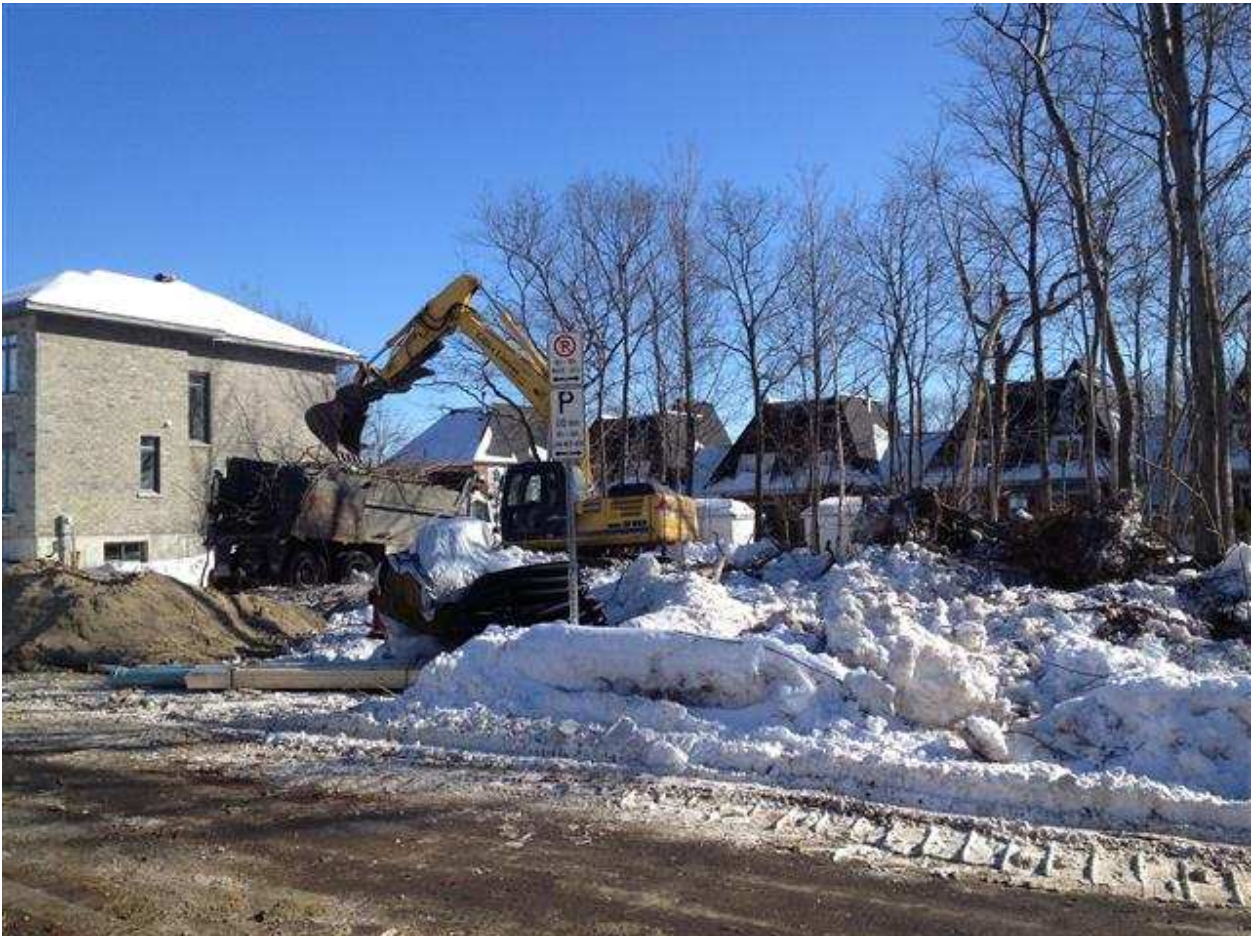
Coupe à blanc d'un terrain sur la rue Paul-Archambault
