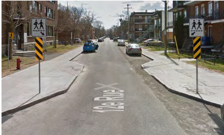
Illustration 21: Dans le quartier Limoilou, la réduction de la largeur de la traverse aux abords de l'école Saint-Fidèle renforce la sécurité des piétons. Photo : Google Maps
