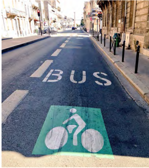
Illustration 14: Corridor vélo-bus à Bordeaux (France). Photo : B. Falardeau
