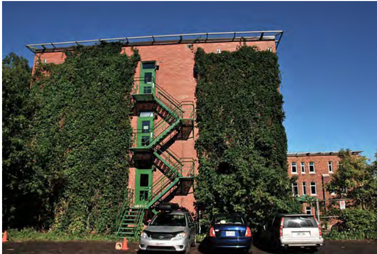
Illustration 38 : Mur végétalisé au Centre culture et environnement Frédéric Back. Photo : Écobâtiment
