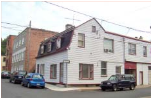
Plusieurs bâtiments ont été rénovés et ont été recouverts, ce qui leur a fait perdre leur cachet patrimonial.
