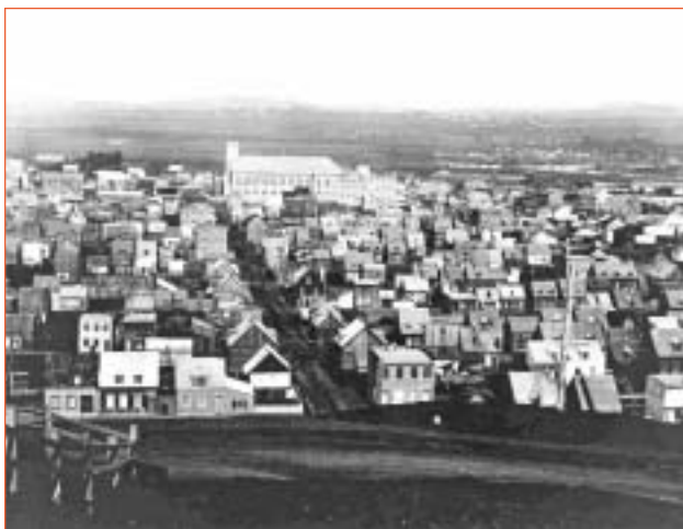
Cette vue de Saint-Sauveur, prise avant le grand incendie de 1889, témoigne de l'état de ce grand faubourg ouvrier avant l'annexion : petites maisons aux toits à pignon construites en bois, rues en terre et sans trottoirs. La photo montre la rue Victoria, qui conduit à l'église de Saint-Sauveur, sans clocher jusqu'en 1892. (Archives nationales du Québec, fonds Vallée GH-271-2).
