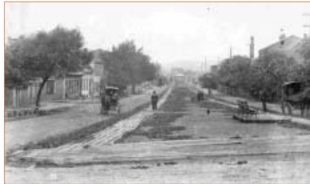
Le boulevard Langelier fait l'objet de travaux d'élargissement à la suite du grand incendie de 1866; on désire ainsi aménager un espace coupe-feu entre Saint-Roch et Saint-Sauveur. En 1885, on le divise en deux voies séparées par un terre-plein central sur lequel on plante une double rangée d'arbres. (Archives nationales du Québec, fonds Philippe Gagnon, N80-1-245).
