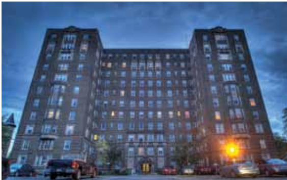
Le château Saint-Louis est construit en 1925 par l'architecte montréalais H.L. Fetherstonhaugh (1887-1971). Photo: Dakx Turcotte - @dakx
