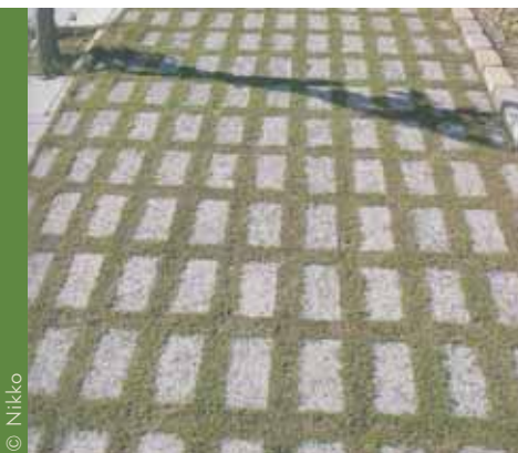
pavés perméables - joint gazon ou gravier
