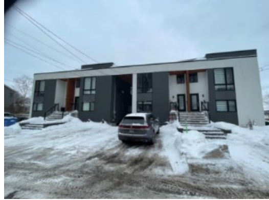
Maison non intégrée plus à l'est (mais du même côté) du chemin du Foulon
