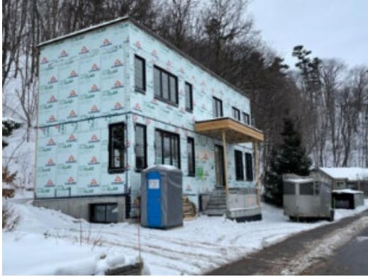
Maison en construction (ancien stationnement) à proximité du 2325 chemin du Foulon
